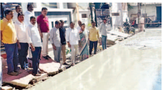
సిసి రోడ్డు పనులు పరిశీలిస్తున్న కార్పొరేటర్ గోపవీణ్ తదితరులు
